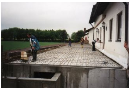
Abbildung 2. Fertigstellung der Kegelbahndecke
