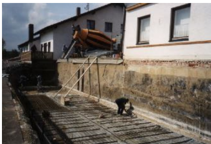
Abbildung 1. Aushub und betonieren der Bodenplatte
